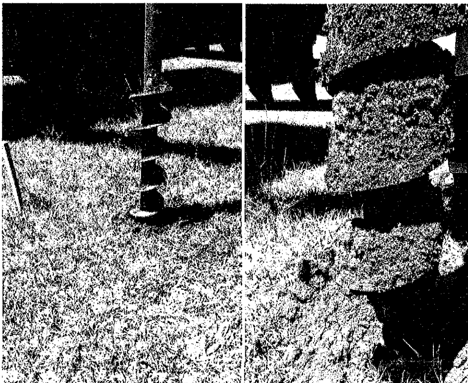
TE10- Perfuração 1: 1,90 cm de profundidade-terra solta- laje
